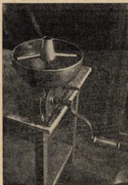
Rys. 2. Przyrząd, zastosowany do ręcznej centrifugi.
