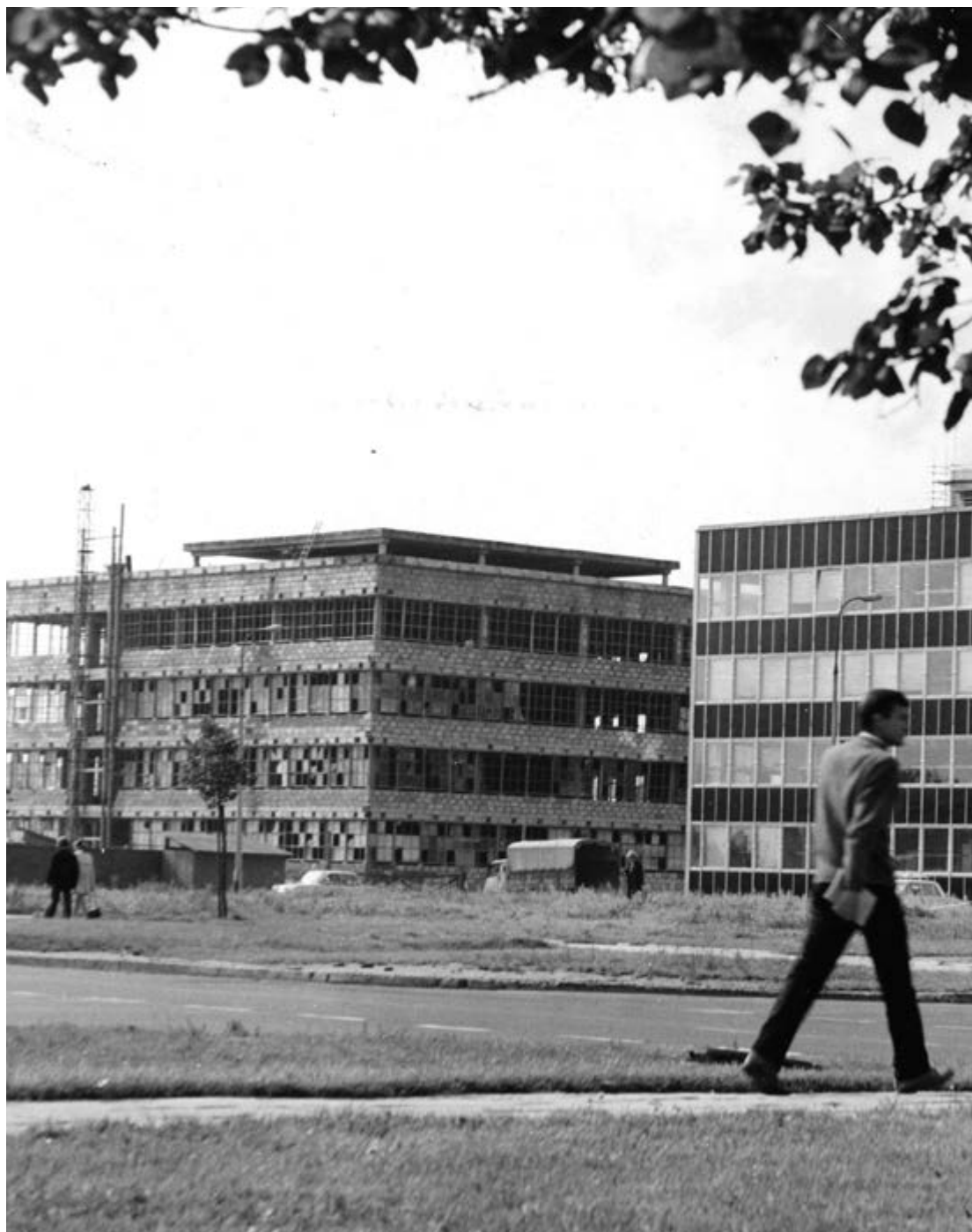
☛ Wydział Farmaceutyczny, blok F2 oraz F3 w budowie, widok od ul. Żwirki i Wigury, wrzesień 1972 r.
